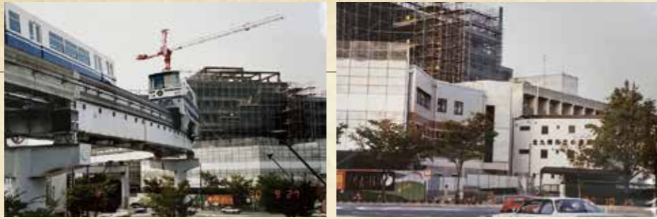
◀本館建築工事
